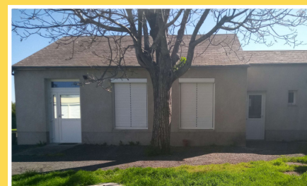
Remplacement de menuiseries à l'école élémentaire d'Ascoux
