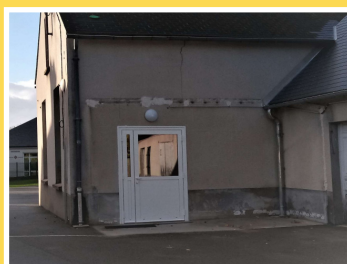
Dépose d'une verrière à la place d'une porte au Groupe scolaire de Vrigny
